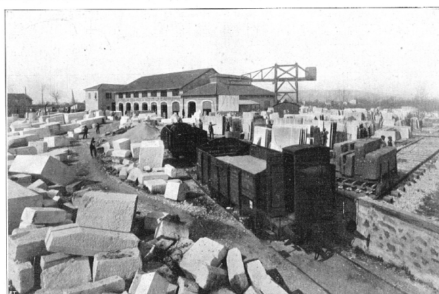
Segheria e deposito marmi.
